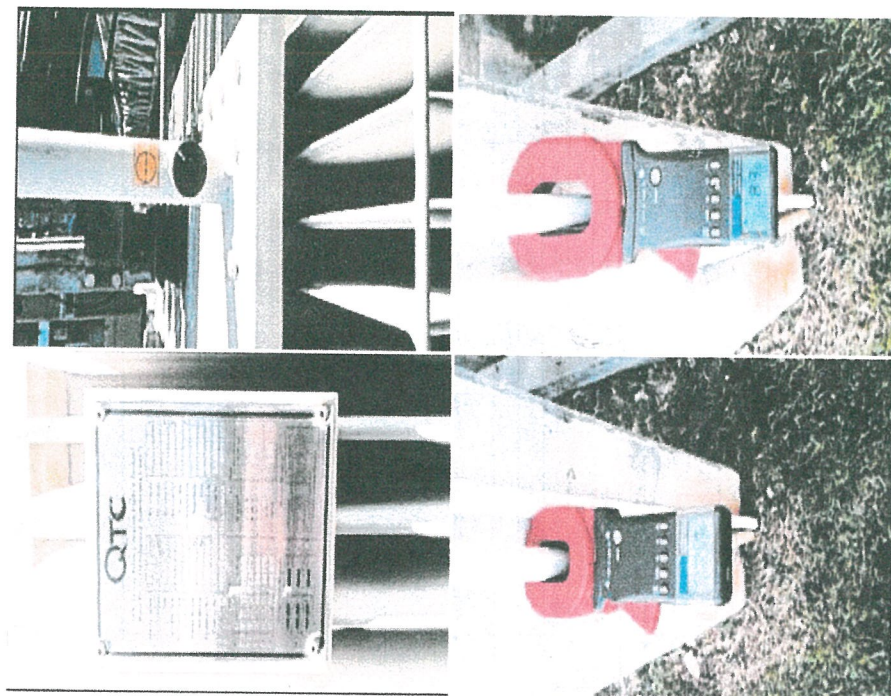
งานตรวจเช็คหม้อแปลงไฟฟ้า 1500 KVA. QTC
